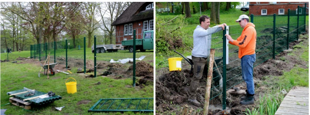
Bau der Zaunanlage um den Bootsanlegeplatz
