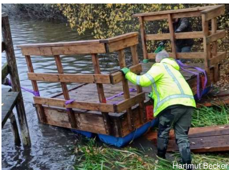
Der renovierte Schwimmsteg wird zu Wasser gelassen
